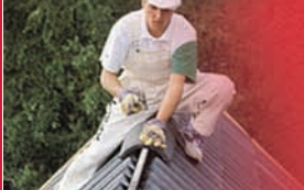
Последняя деталь жесткости разжелобка
