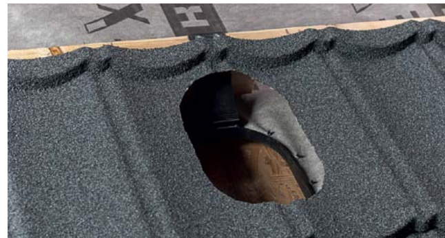
Рис. 39 а. Проходной элемент (DECRA) для панели Classic
